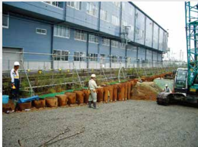
日本鉄道建設公団 九幹鹿 第一蓮台寺BL他工事
