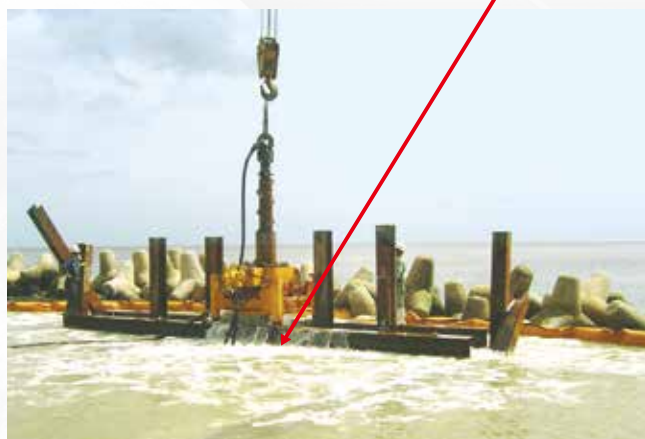
水中施工でもロータリーテーブルマシンが泥水を受け止める
