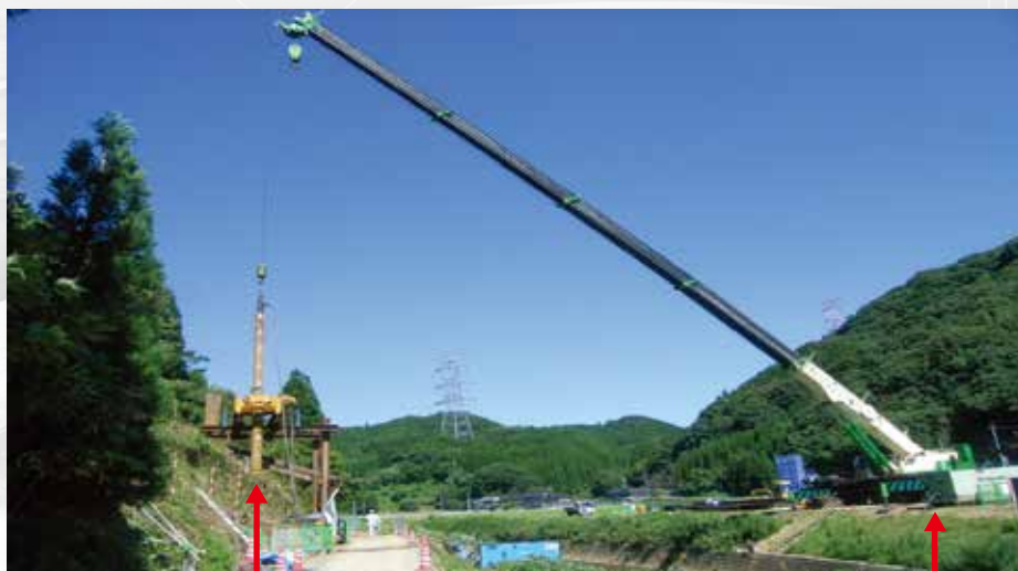
杭芯～旋回軸 41m (200 tトラッククレーン施工)
