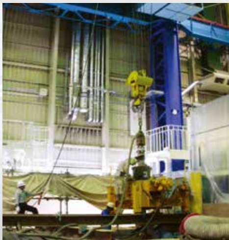
トヨタ九州工場成形棟レール基礎工事
